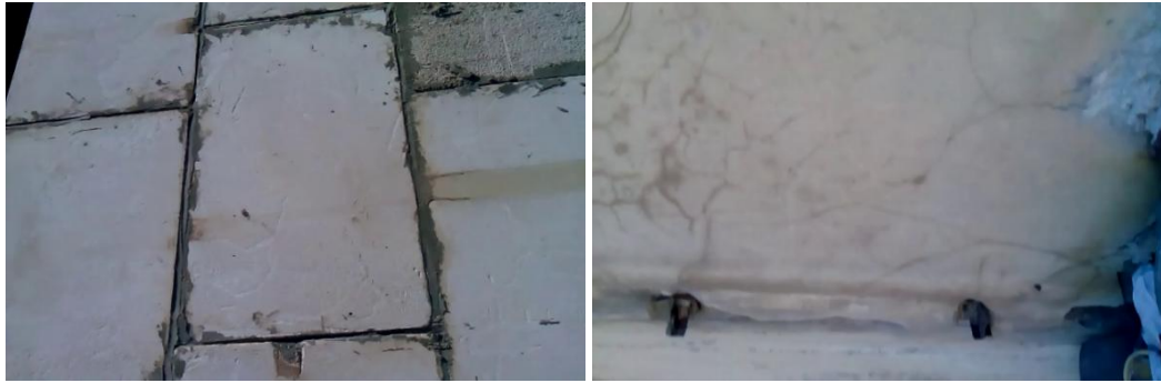
Photo : Bâtiment servant de stockage aux fûts contenant du PCB (ICS-MBAO)
